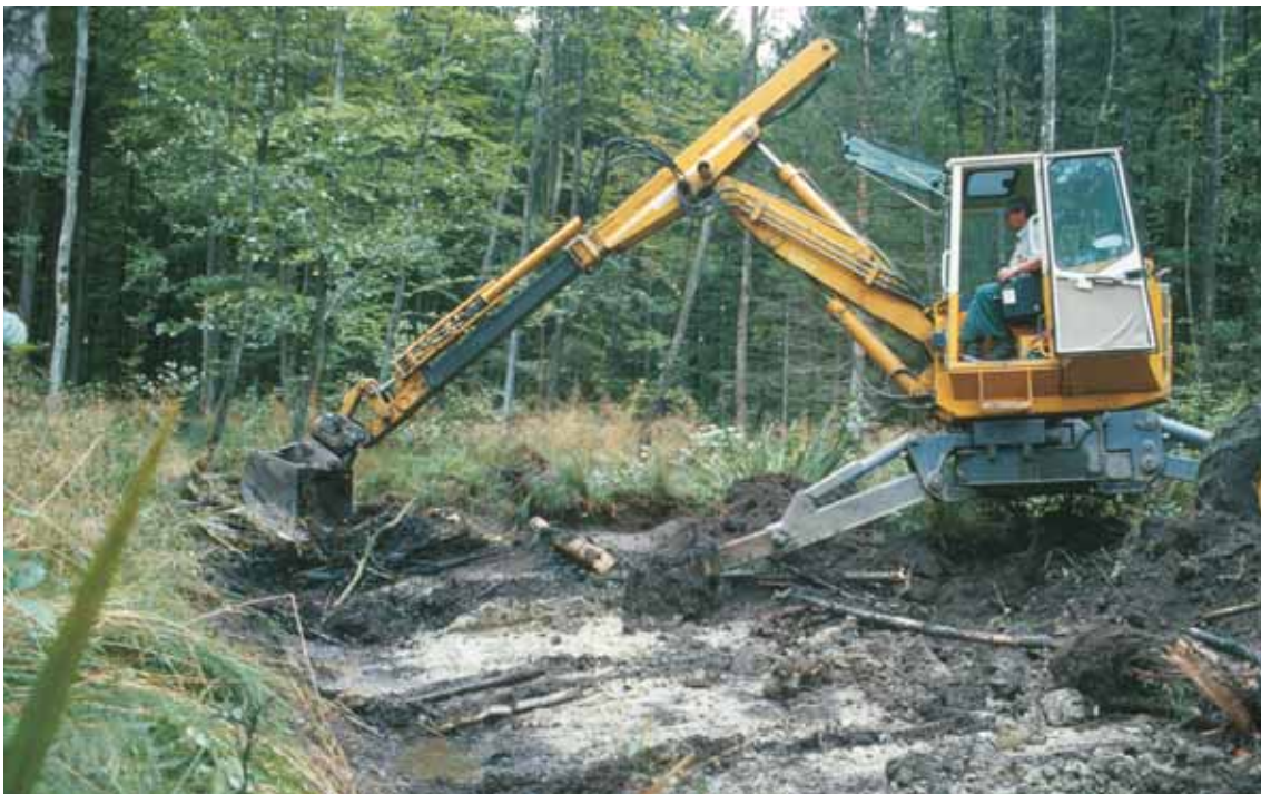
Bild 38: Mit dem Schreitbagger konnten die neuen Tümpel und Mulden ausgehoben werden, ohne allzu viel der Flora zu zerstören.
