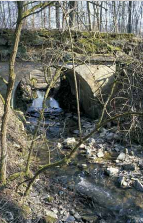
Bild 14: Brücke mit durchgehendem Ufer.
